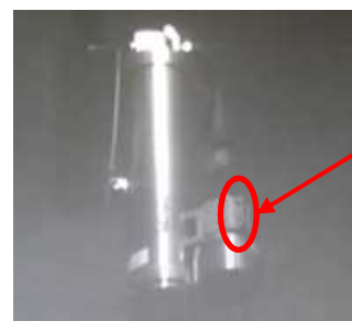
<水中カメラの接触箇所>
