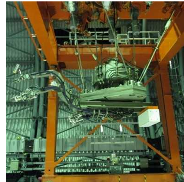
テンシルトラス吊上げ状態
