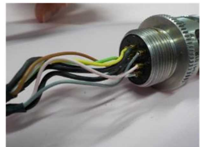
分解後 (メス側，異常なし)
