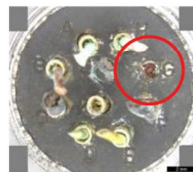
⑤接続部内部 (清掃後)
