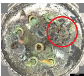
②接続部内部 (リード線切断後)
