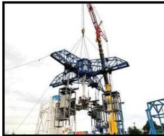
鉄塔解体装置吊り上げ状況
