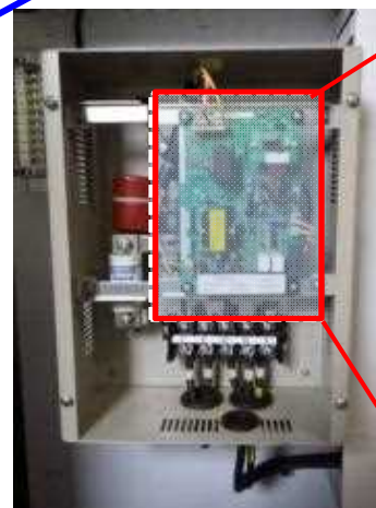
ブレーキユニット表蓋を外した状態（交換前）
