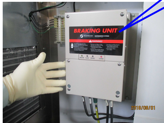
ブレーキユニットの外観（交換後）
