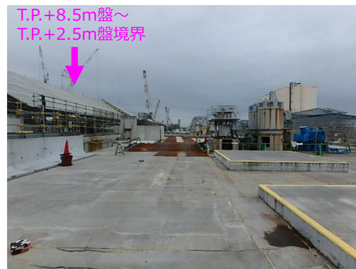
4号機側 T.P.+2.5m盤 (フェーシング工事が進捗)
