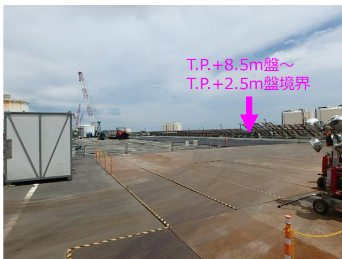
4号機側 T.P.+8.5m盤 (フェーシング工事が進捗)
