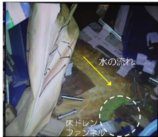
図 4.3.3-4 3号機 MSIV 室扉付近からの漏水の確認 [3-5]
