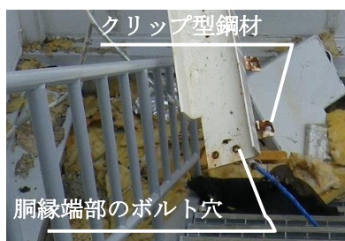
(B) 胴縁端部のボルト穴
