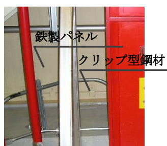
(A) 鉄製パネルと胴縁の接続
