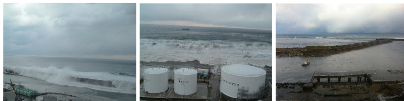
北防波堤の被害状況※ （左図：津波越波直前，中図：津波越波直後（上部工などの転倒），右図：津波引き波時）
