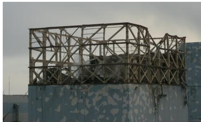
図 1号機原子炉建屋の外観写真
