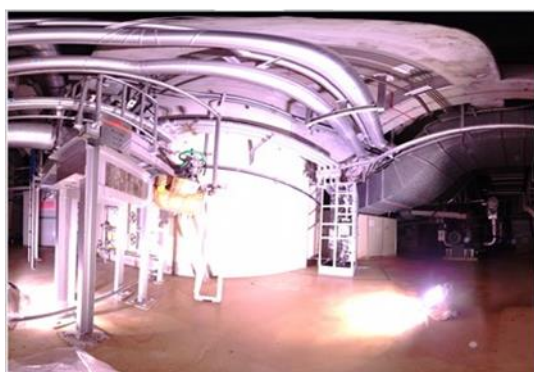
3階シェル壁北東面（写真）
