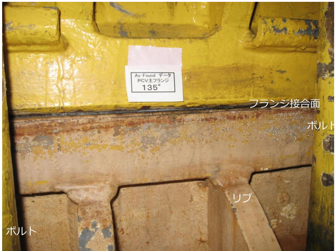
図 2- 38 事故前の PCV 蓋のフランジ部の状況 [2-22]
