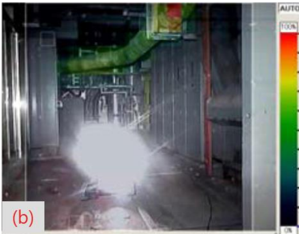
図 3.2.3 1階南東エリアのガンマカメラ写真(2) (2013年12月) [6]
