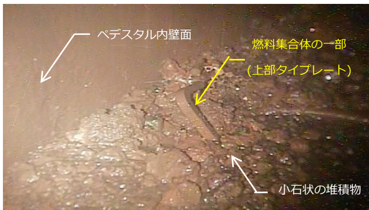
図6 2号機 ペDESTAL底部の様子 (その2) [2]
