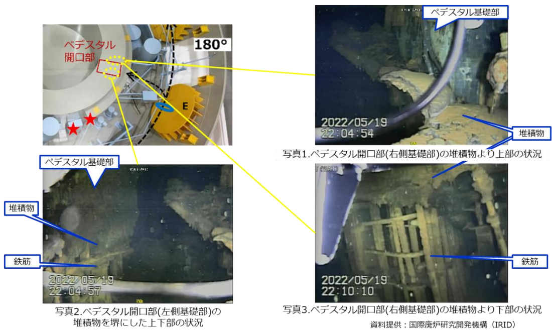
図 2- 68 ペDESTAL開口部 (基礎部) 付近の状況[2-31]
