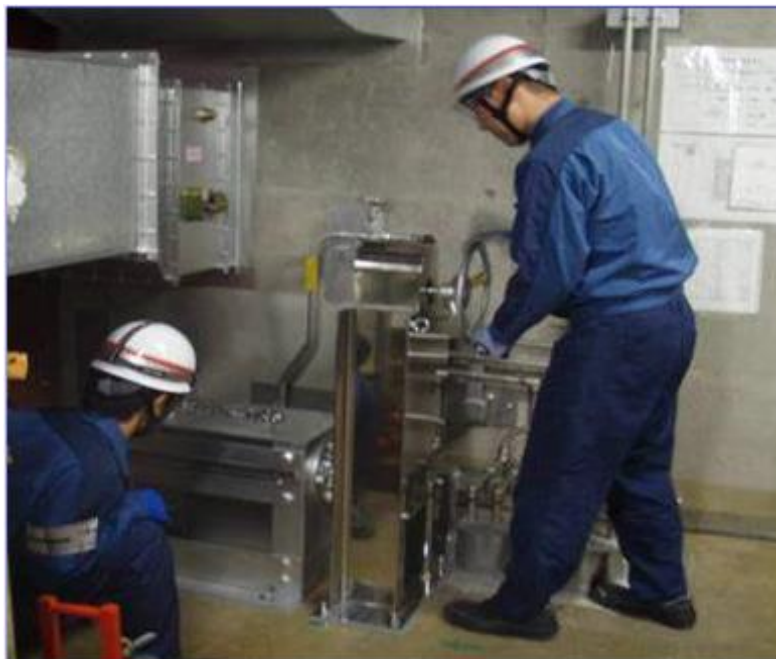
図 4.3 遠隔手動操作装置の操作の様子
