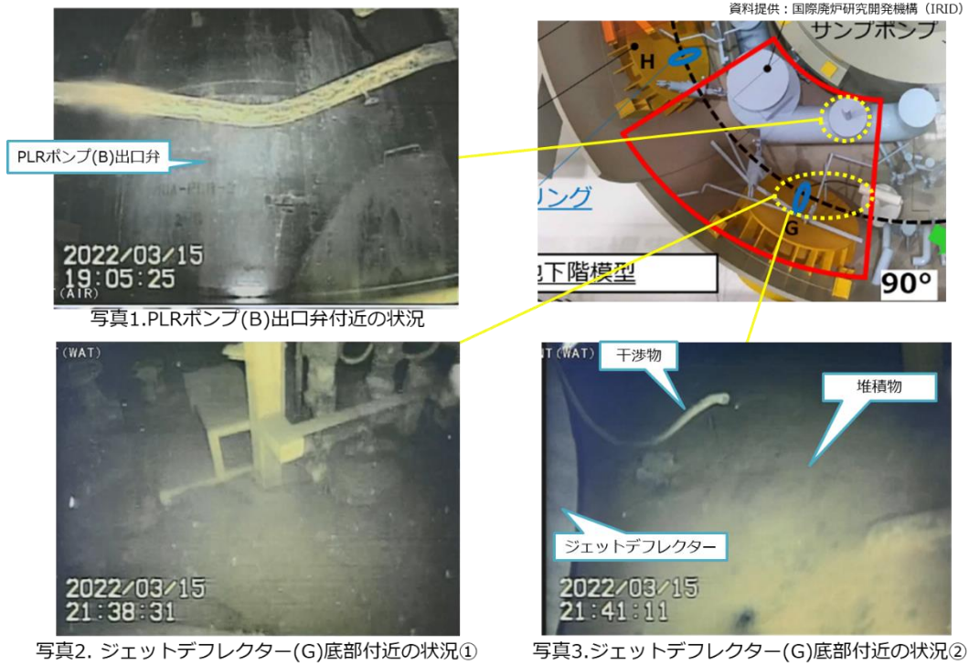
図 2-57 PLR ポンプ(B)付近および ジェットデフレクター(G)付近の状況[2-32]
