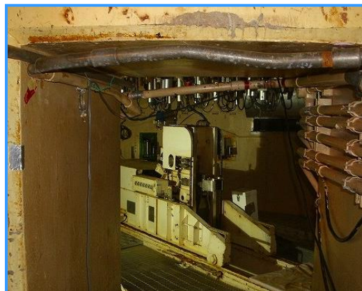
(参考) 5号機ペDESTAL開口部
