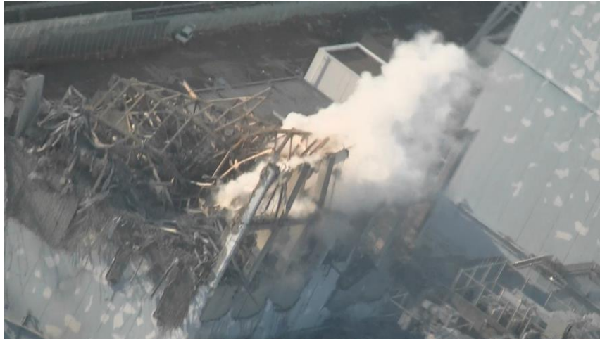
図 12 3号機空撮写真 (2011年3月16日撮影)
