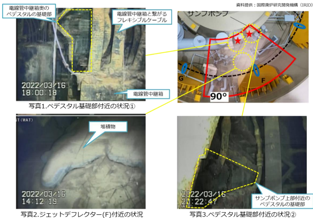
図 2-59 ペDESTAL付近およびジェットデフレクター(F)付近の状況[2-32]
