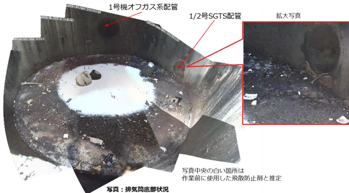
図 2- 42 排気筒底部の状況 [2-25]
