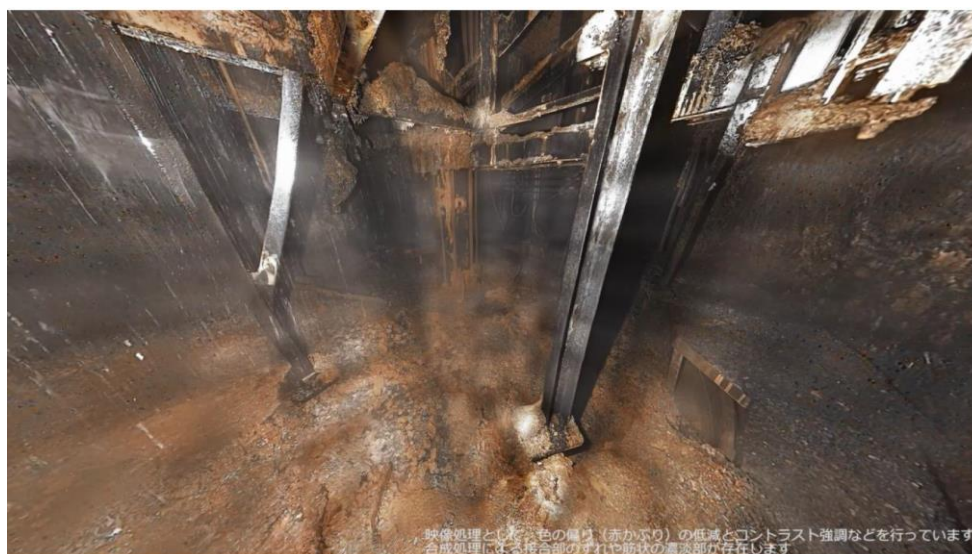
図 4.9.2-3 2号機ペDESTAL内部の画像 (1/3) [2-21][2-22]
