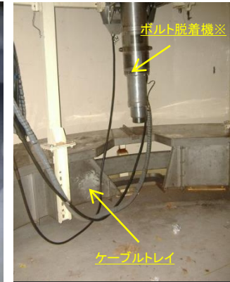
(参考) 2号機定検時 ※運転時には上記構造物はPCV内より撤去
