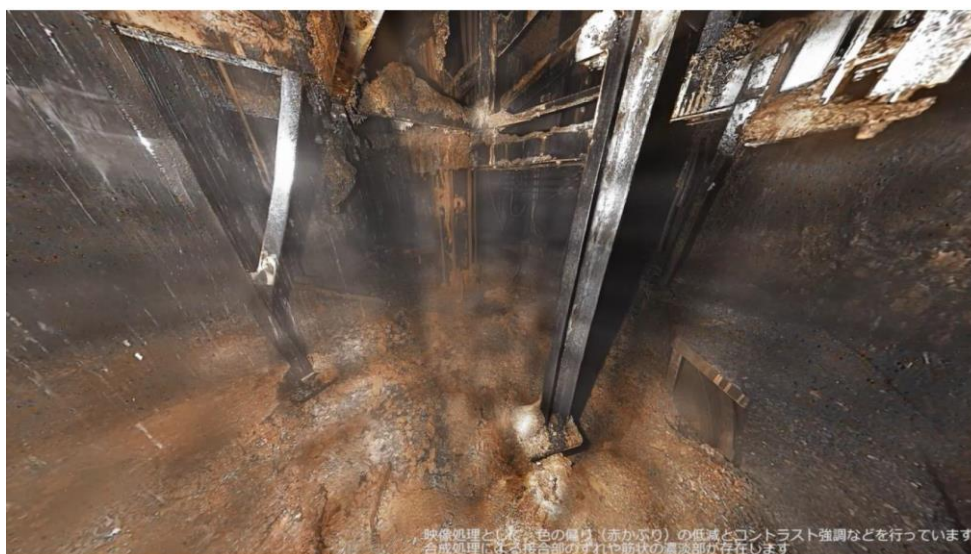
図 4.9.2-3 2号機ペDESTAL内部の画像 (1/3) [2-21][2-22]
