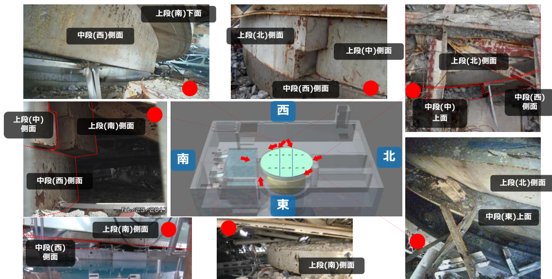
図 2-23 オペレーティングフロア上でのウェルプラグ状況確認結果 [16]
