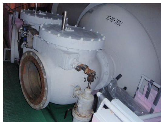
図2 真空破壊弁
