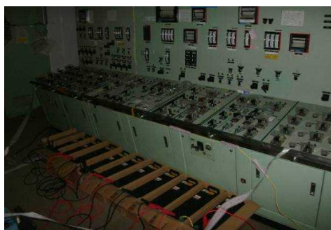
職員の通勤用乗用車のバッテリーを必要な計器につなぎ込み
