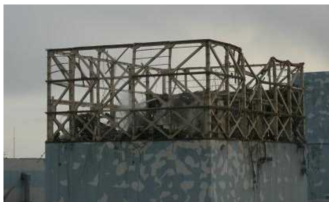
図 1号機原子炉建屋の外観写真
