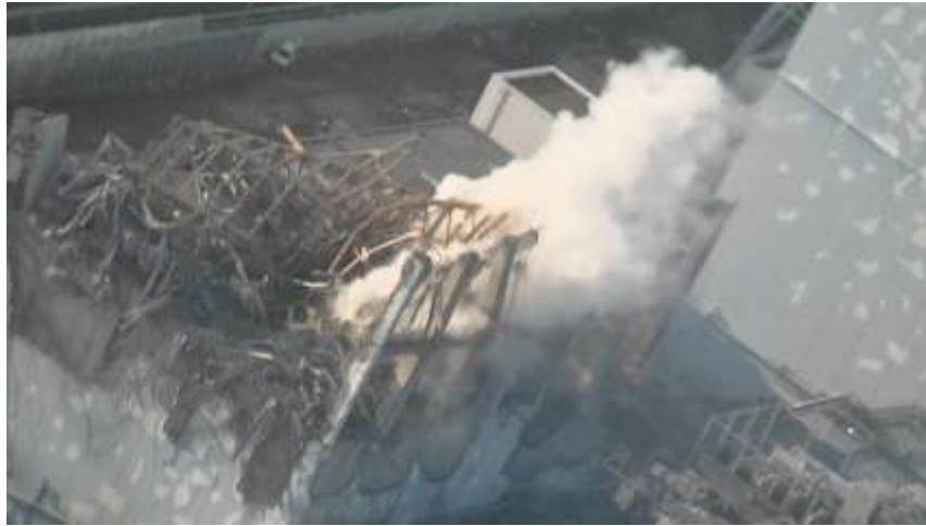
図 12 3号機空撮写真 (2011年3月16日撮影)
