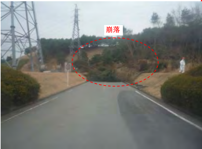
防災道路ではないが斜面崩落し道路が塞がれ通行不可能。 3/20撮影
