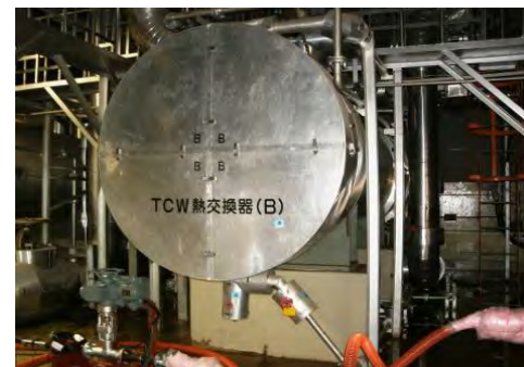
タービン建屋補機冷却系熱交換器
