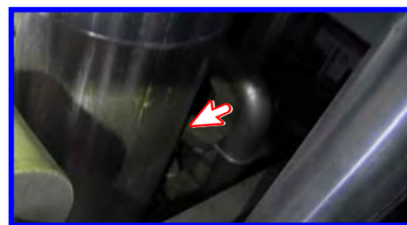
IC(B)凝縮水戻り配管
