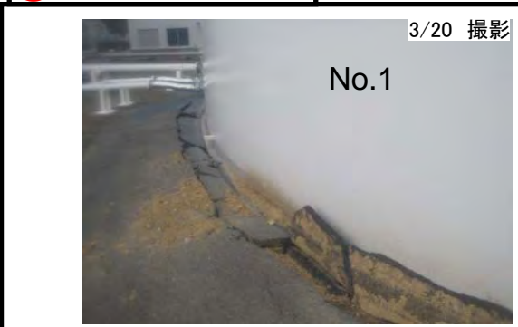
・タンク下部に座屈による歪みが発生
