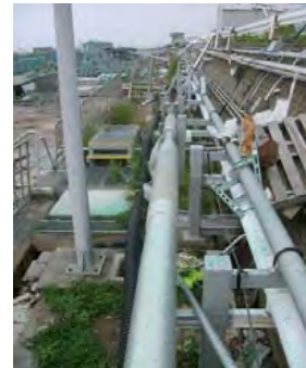
⑧ 消火配管(FP-201)
