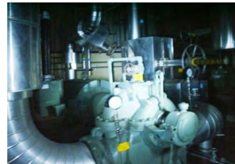
タービン建屋補機冷却系ポンプ
