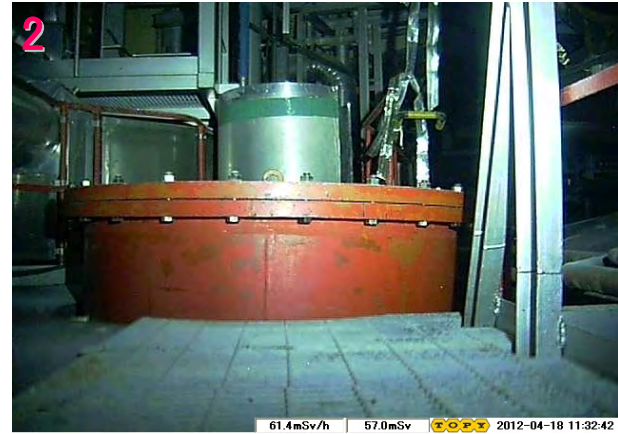
2 南東S/Cマンホール
