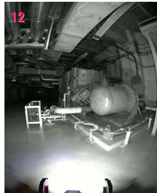
可燃性ガス濃度制御系 ・機器には外観上異常なし
