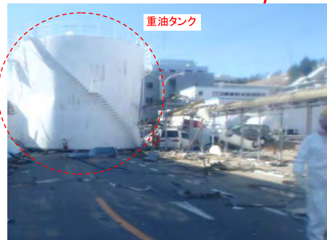
道路に大きな損傷はないが、津波で流された重油タンクが道路を塞ぎ、通り抜け不可能。 3/17撮影
