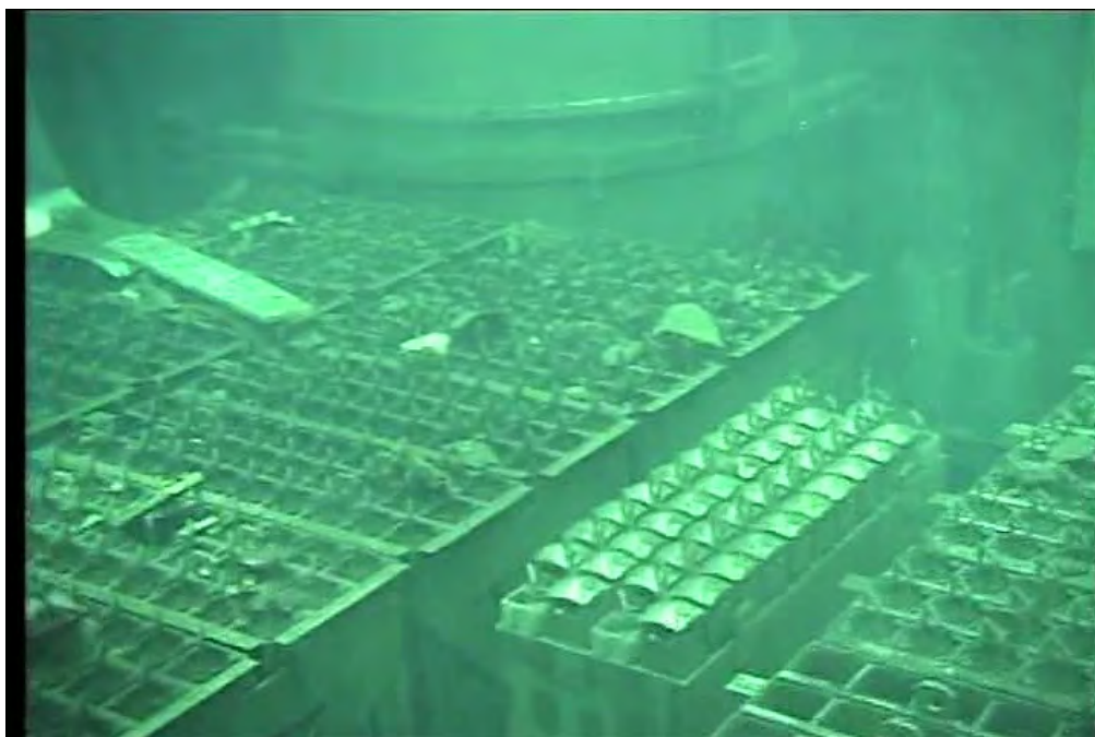
図6 4号機のSFP水中の状況(その1)
