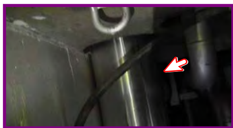
IC(A)凝縮水戻り配管
