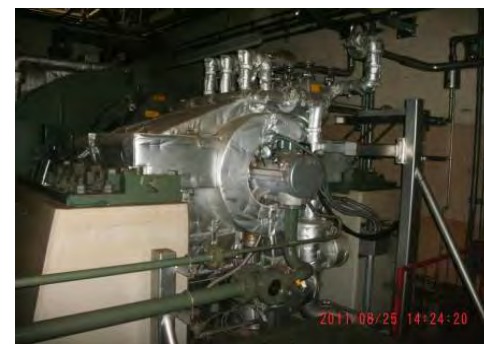
タービン駆動原子炉給水ポンプ
