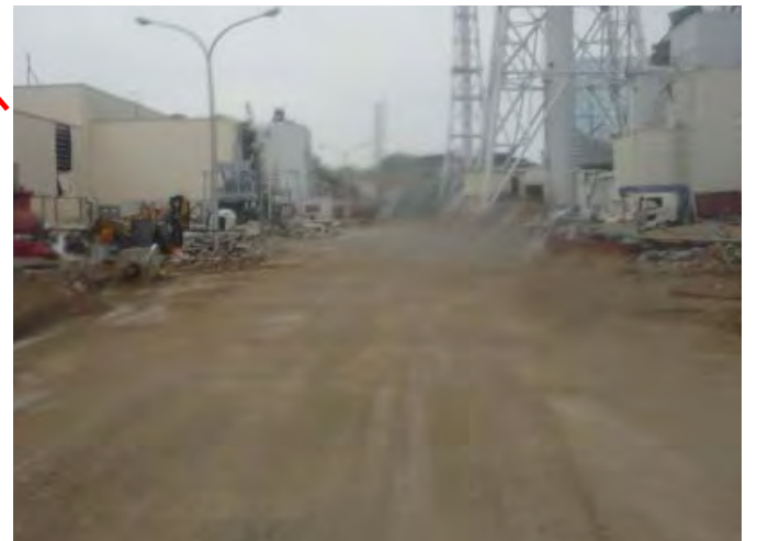
1~4号機西側道路は特に異常なし。1,3,4号機原子炉建屋の損壊時には瓦礫散乱があった。 3/20撮影
