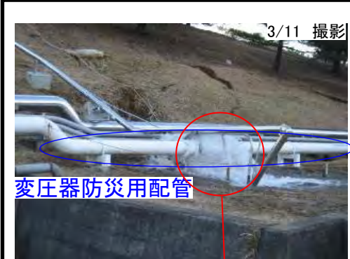
・変圧器防災配管(ろ過水タンク水源)連結部の脇にある別配管のサポートが斜面の崩れにより傾き、当該連結部に接触し漏水発生
