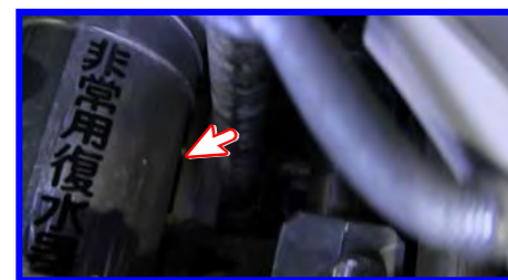
IC(B)凝縮水戻り配管
