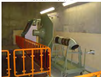
新たにサポート器具を設置
