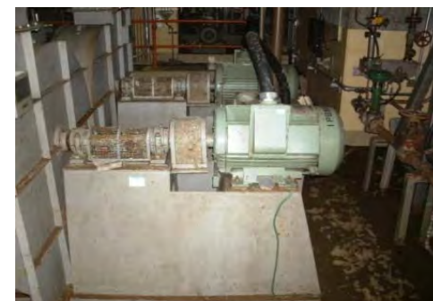
相分離母線冷却ファン
