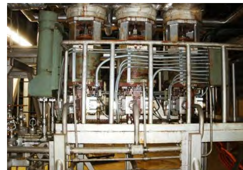
主タービン蒸気加減弁
