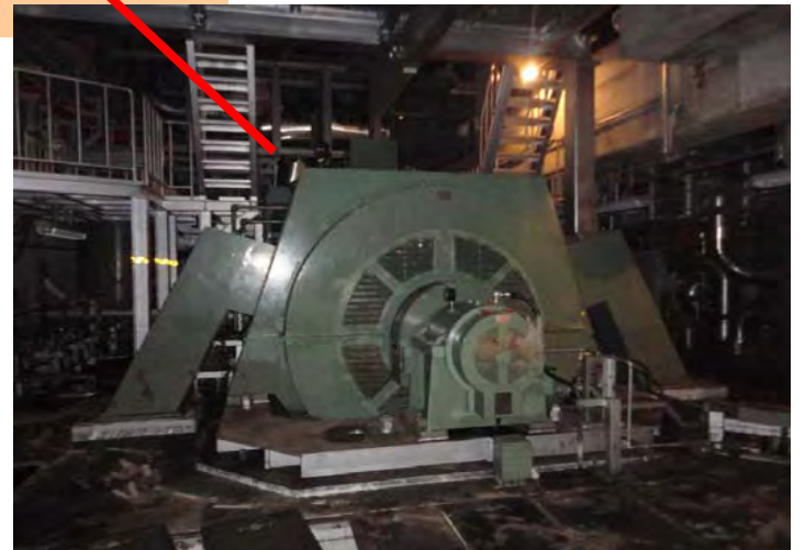
非常用ディーゼル発電機
