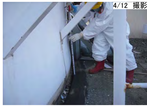
・タンク下部に座屈による歪みが発生
