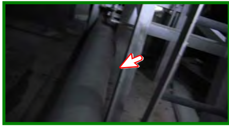
IC凝縮水戻り配管
