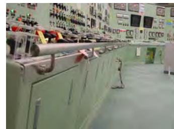
中央制御室の操作盤に 手摺りを設置
