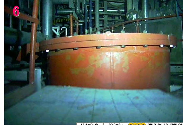
6 北S/Cマンホール
