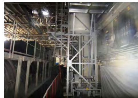
タービン建屋補機冷却系サージタンク
