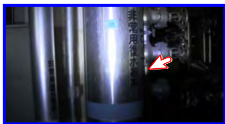
IC(A)凝縮水戻り配管
