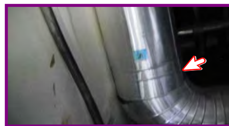
IC(A)凝縮水戻り配管
