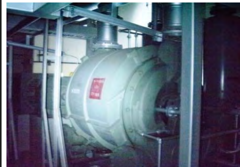
復水器真空ポンプ
