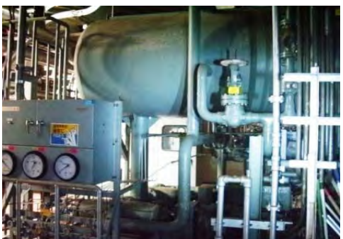
発電機密封油装置
