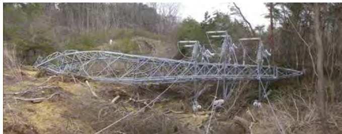
図2 夜の森線No.27鉄塔
