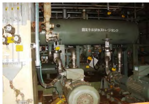
固定子冷却装置
