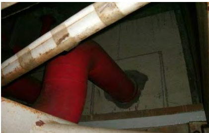
⑭ 消火配管(トレンチ内) ・トレンチ内の配管には外観上大きな損傷はない
