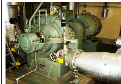
タービン建屋補機冷却系ポンプ
