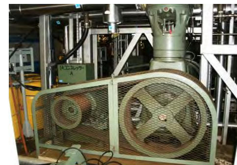
計装用空気圧縮機
