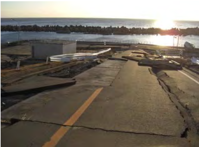
道路補強工事を実施した箇所であるが、補強していない道路両脇に割れ及び段差が発生。 3/17撮影
