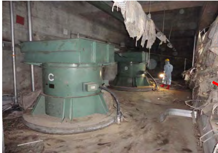
吸気ルーバ(内側から)
