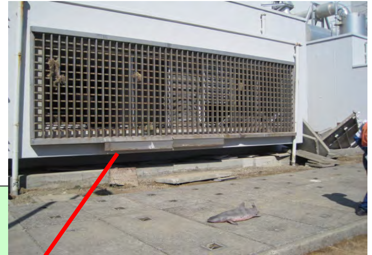
吸気ルーバ(外側から)
