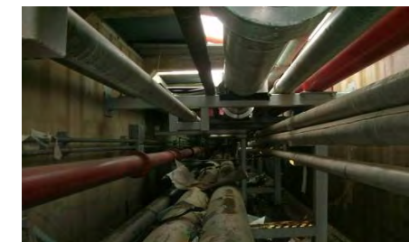
⑭ 消火配管(トレンチ内) ・トレンチ内の配管には外観上大きな損傷はない
