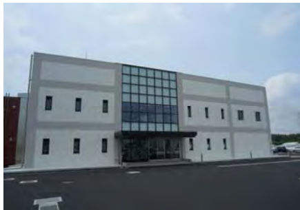
免震重要棟外観
