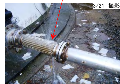
・地震後漏洩が発生し、タンク出口元弁閉後の状況
