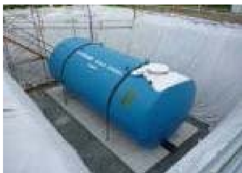
埋設の防火水槽（設置時のもの）
