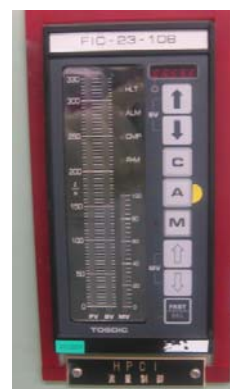
HPCI 流量制御器 (FIC) (後日撮影)
