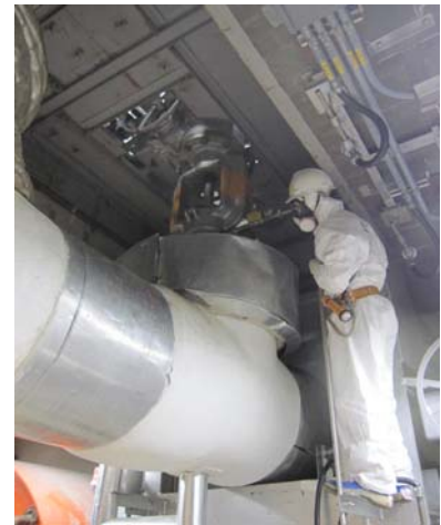
直径約60cmの配管に設置されているRHR注入弁(5号機 照明あり)
