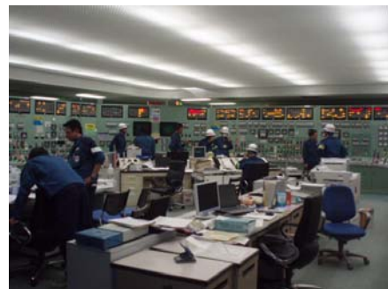
5/6号中央制御室：6号機側
