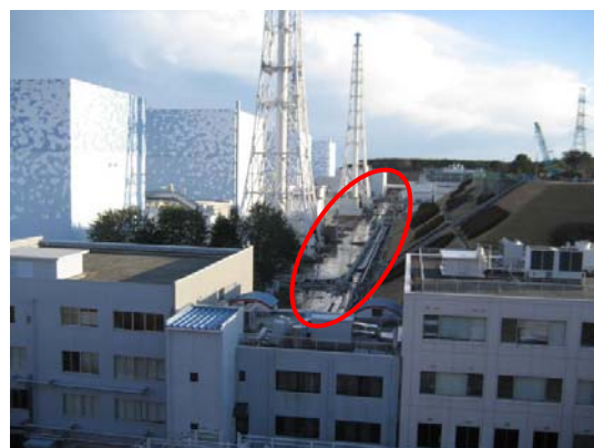
津波により 1~4 号機全域が浸水
