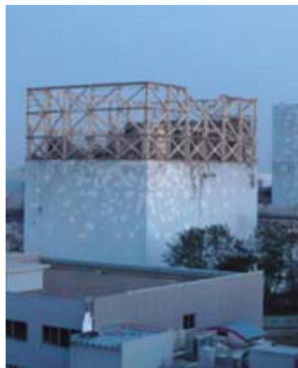
爆発後の1号機原子炉建屋
