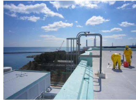
屋上での作業状況
