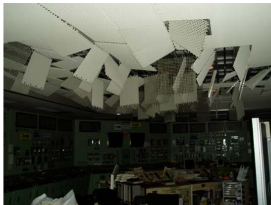
爆発後の中央制御室の状況
