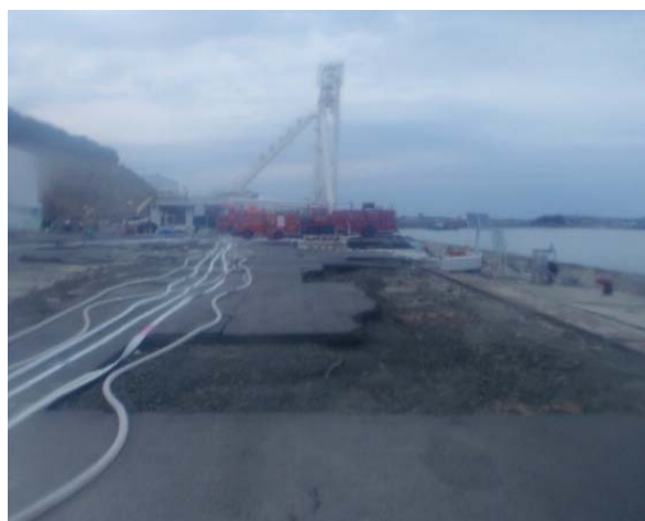
物揚場からの消防車による注水
