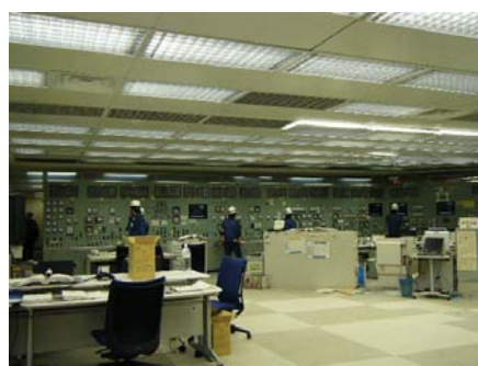
津波到達後の中央制御室
