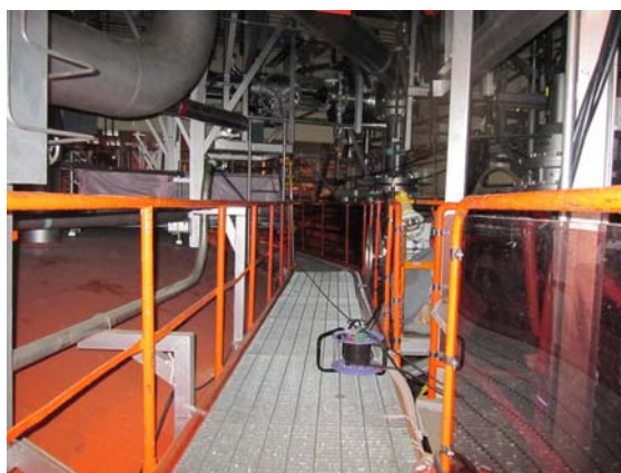
キャットウォーク (5号機, 照明あり)
