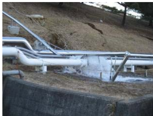
変圧器防災配管の漏えい
