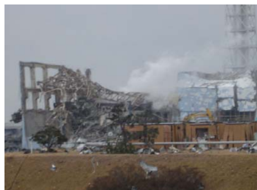
4 号機損傷状況（写真右） （写真左は 3 号機）
