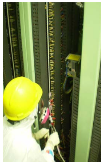
制御盤裏 (後日撮影 照明あり)
