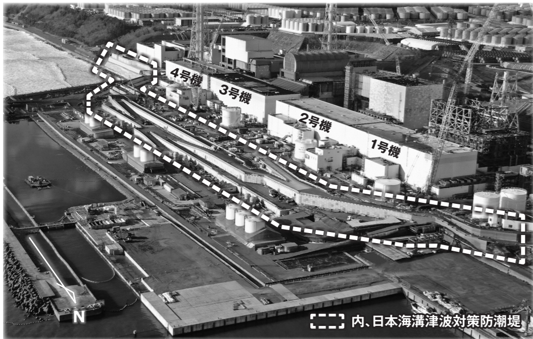
日本海溝津波対策防潮堤 設置状況全景（2024年3月2日撮影）
