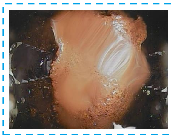
底部-6の調査状況
