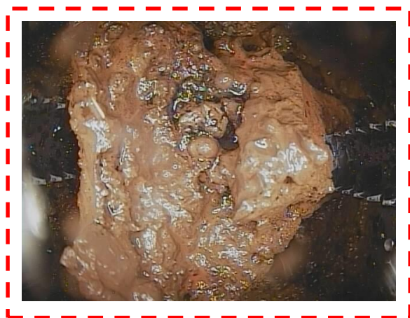
底部-5の調査状況
