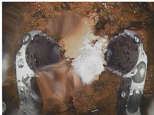
底部-1の調査状況
