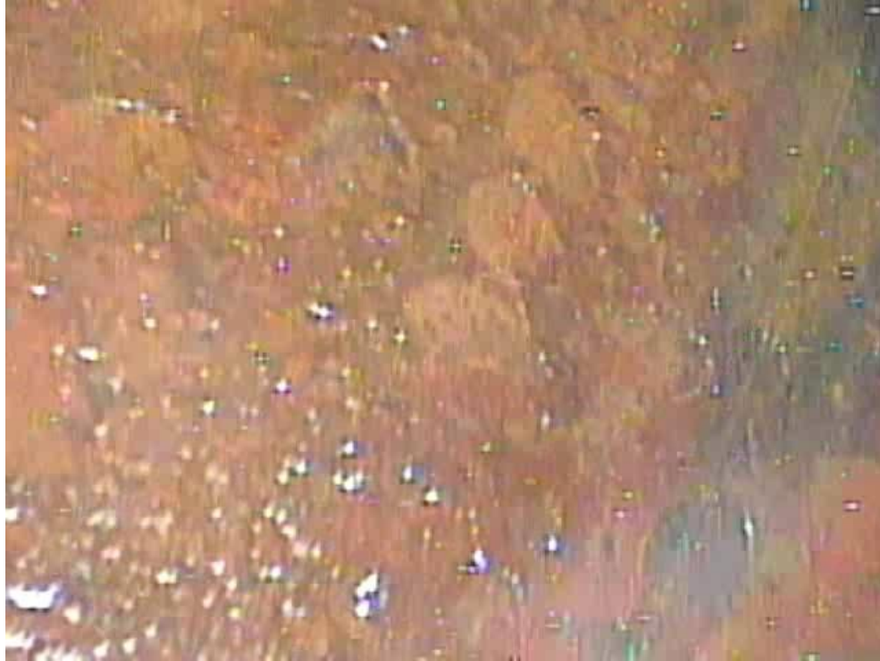
原子炉格納容器内壁
