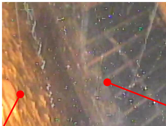
原子炉格納容器内壁
