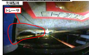
〈先端監視カメラ映像〉トレーサ投入状況
