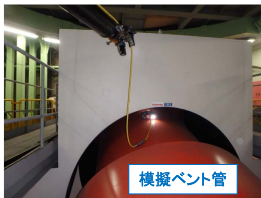
D/Wーベント管接合部調査装置工場試験
