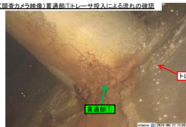
〈調査カメラ映像〉貫通部①トレーサ投入による流れの確認
