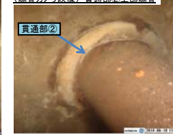
〈調査カメラ映像〉貫通部②トレーサ投入による流れの確認
