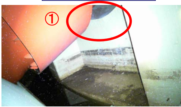
ベント管スリーブ端部
