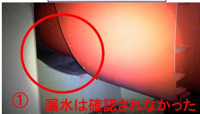
ベント管スリーブ端部
