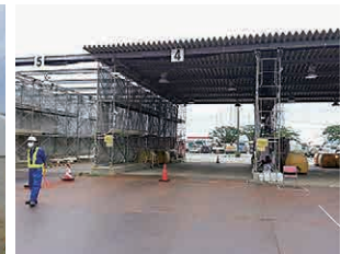
車両除染場外観
