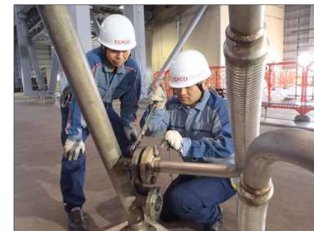
[配管取り付け作業の研修風景]
