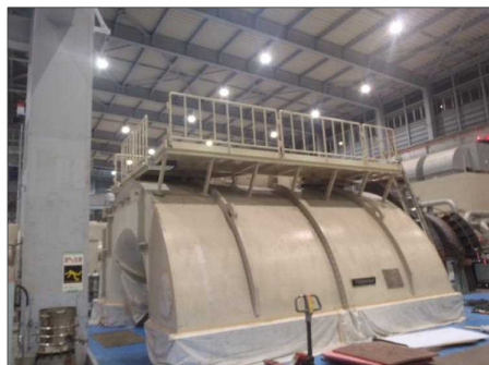
[蒸気タービン分解用の架台組立状況]
