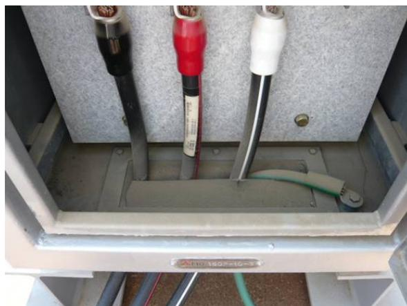
現場調査状況の例：変圧器内部の点検を行った結果、ケーブル入線部（写真右）に開口部の未処理を確認したため、閉止処置を実施
