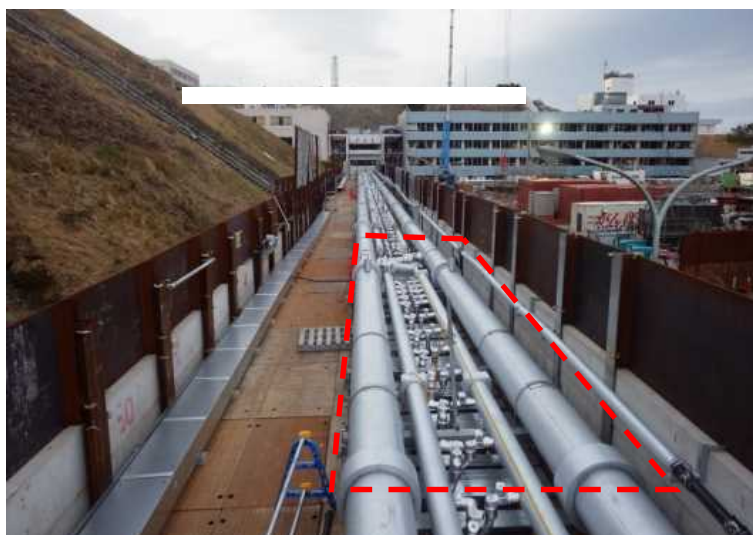
図－3 配管類撤去箇所の例
