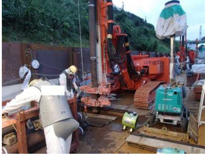
図-4 ボーリング削孔（イメージ）
