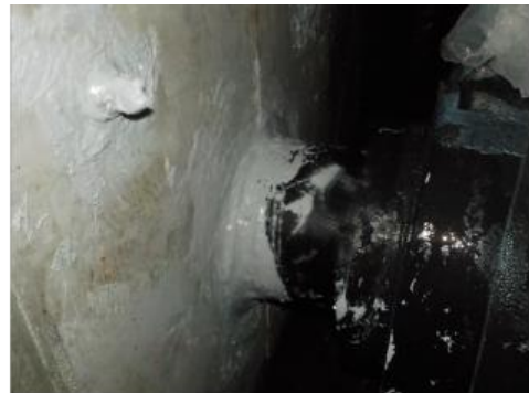
内堰内側の止水処置実施状況
