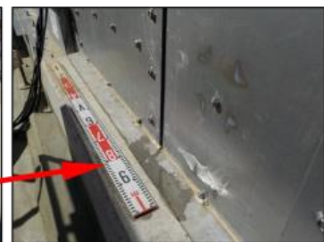
ボルト部の止水処置状況 (一部)
