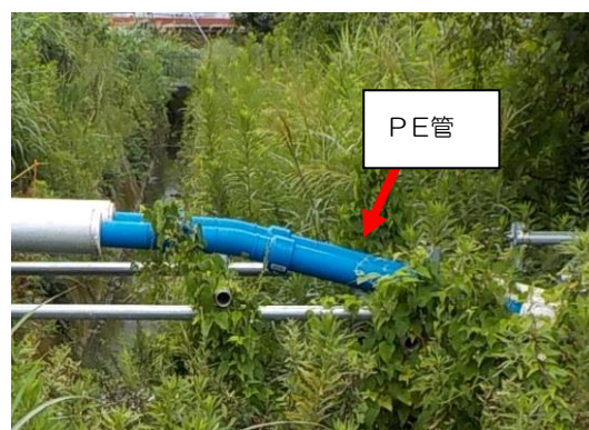
漏えい箇所下流側のPE管敷設状況
