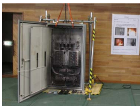
作業中の短絡により発火・延焼した分電盤の実物展示 （低圧電気短絡体験の災害事例紹介）
