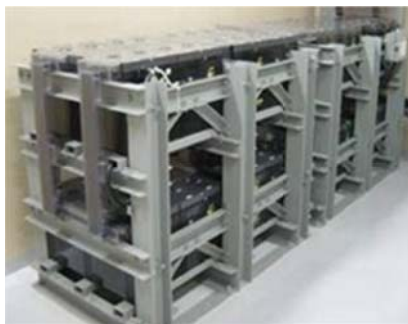
原子炉建屋4階に直流125V蓄電池を追加設置（耐震架台付）
