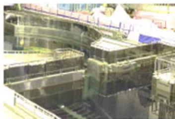
使用済燃料プールゲート閉止作業前
