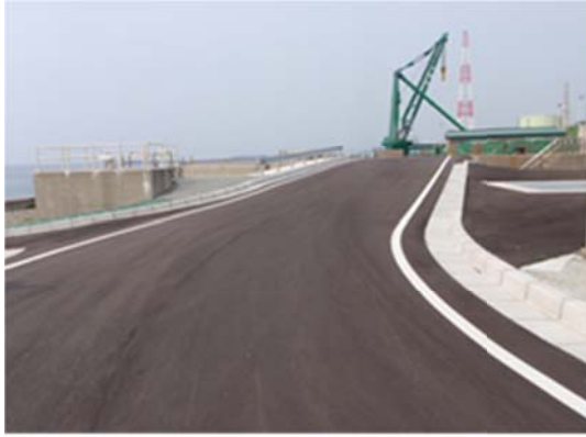
1～4号機側から5～7号機側へ向かうために追設したアクセスルートの外観
