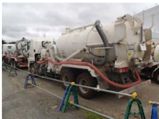
同型の工事車両
