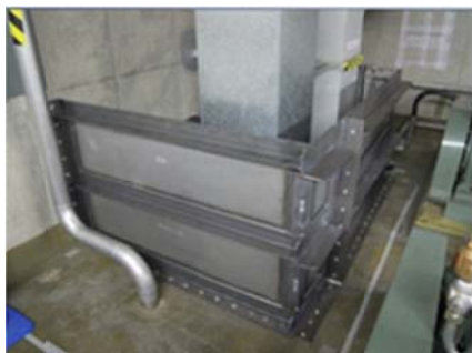
鉄板堰囲いによる止水対策
