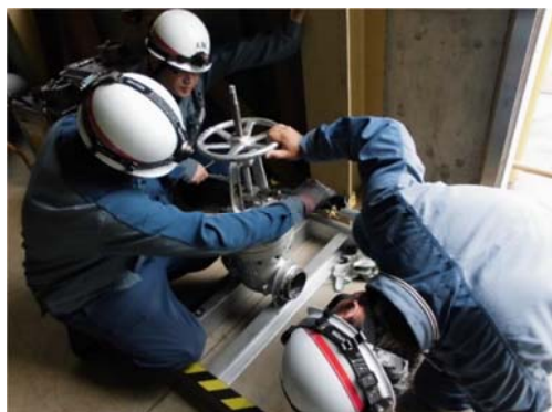
直営による弁の分解点検
