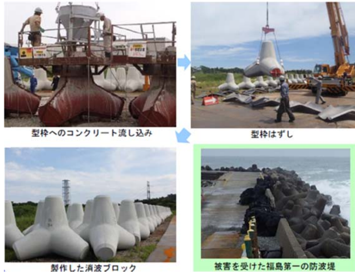
福島第一南防波堤用消波ブロックの製造作業
