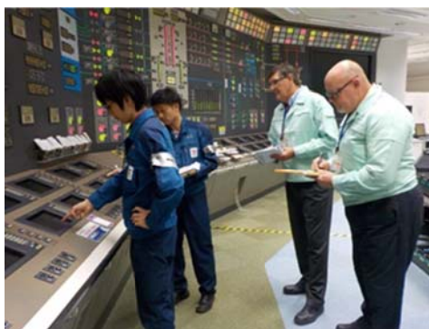
エキスパートチームによる運転操作のオブザベーション
