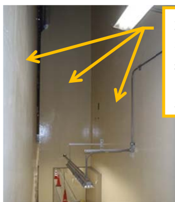
耐火壁の設置（防火塗料の塗布）
