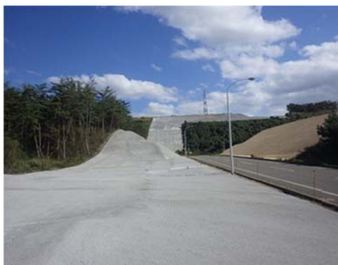
発電所構内における防火帯の設置
