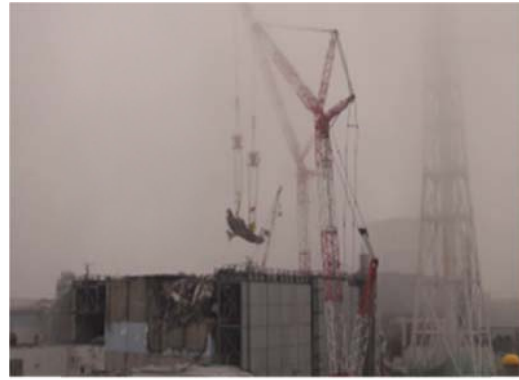
3号機 燃料交換機の吊り上げ作業
