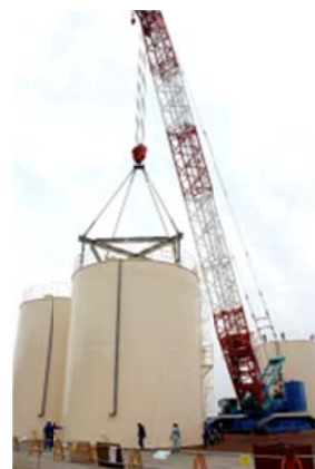
物揚場へのタンクの陸揚げ
