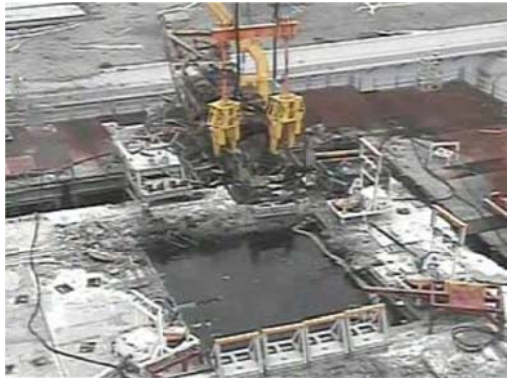
3号機 燃料交換機の吊り上げ作業
