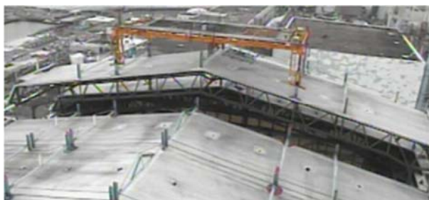
1号機 建屋カバー屋根解体作業
