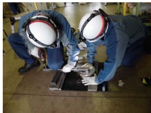
直営による弁の分解点検
