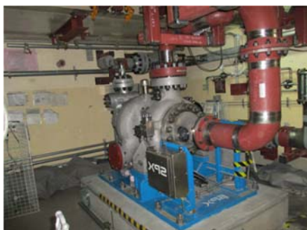
高圧代替注水系ポンプ設置工事の状況
