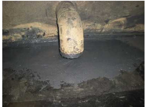
底板ドレン配管近傍
