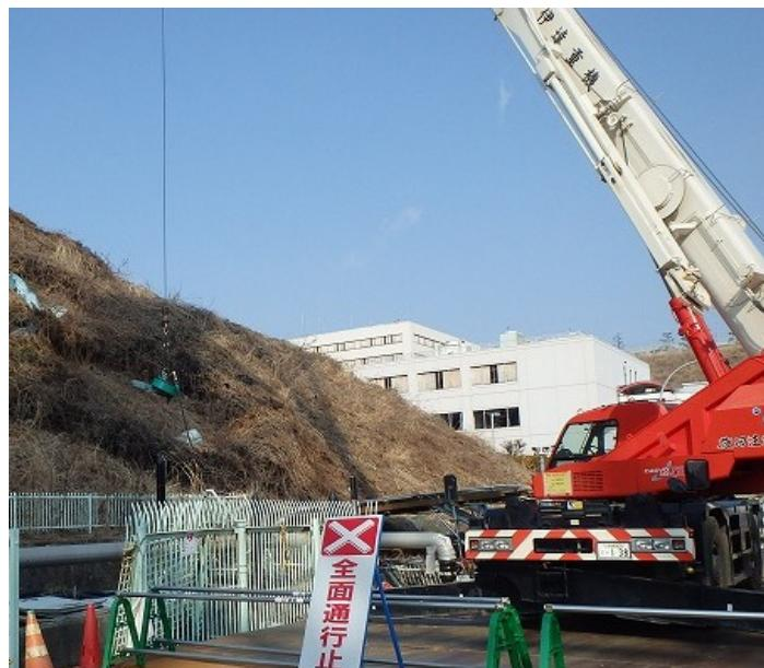
1・2号原子炉建屋西側斜面において、飛散ガレキの除去を実施した。
