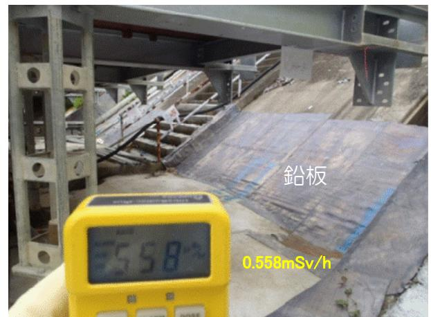
2号機原子炉建屋山側で、被ばく線量低減対策（鉛板設置）を実施し、簡易放射線測定器※で測定した結果、空間線量率は半分以下に低減した。
