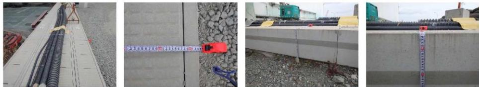
図 16-24 【8-1】滞留水移送管 施工方法（複列施工）
