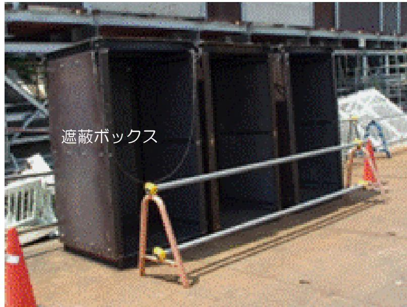
作業待ち時間中の被ばく低減のため、一時退避できる遮へいボックスを設置。
