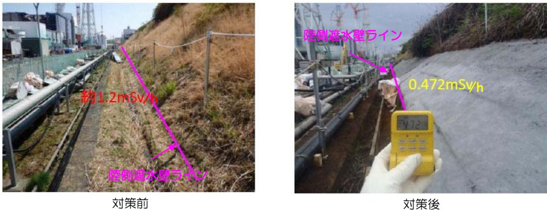
1号機原子炉建屋山側で、被ばく線量低減対策（側溝清掃、表土すきとり、被覆）を実施し、簡易放射線測定器<sup>\*</sup>で測定した結果、空間線量率は半分以下に低減した。
