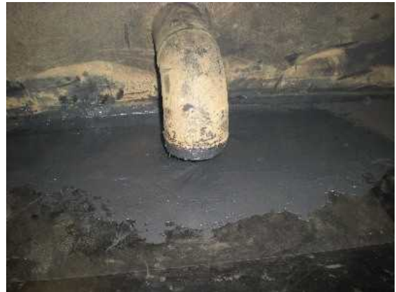
底板ドレン配管近傍
