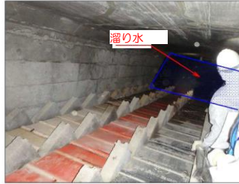
内部写真 (溜り水)
