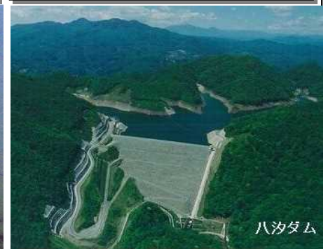
八汐ダム・調整池全景
