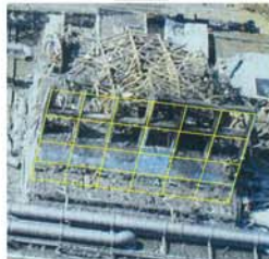
②東面 外壁
