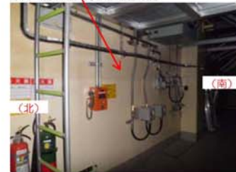
⑤基礎設置部 (東側、内部)
