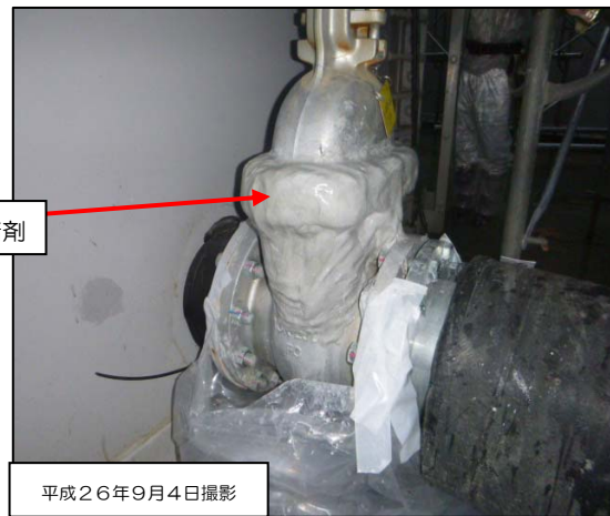
接着剤塗布後の写真
