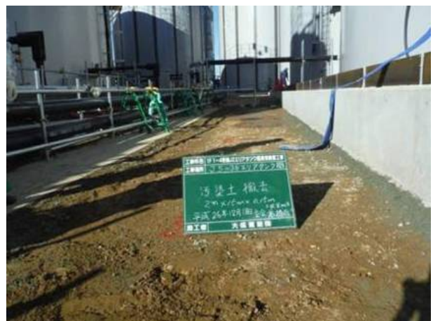
土砂回収後 (写真は逆方向から撮影)
