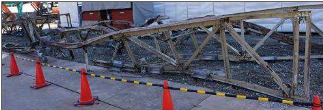
トラス梁の全景⑥(2015年4月撮影)
