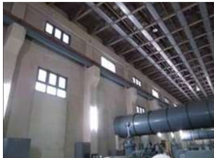
発電機室内観（南面）
