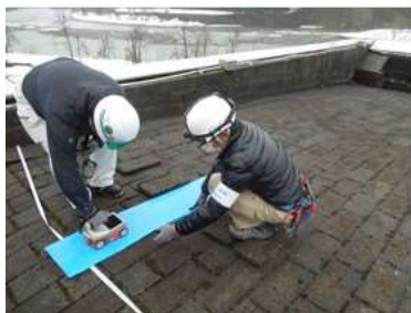
スラブの厚み調査（測定器による非破壊調査）
