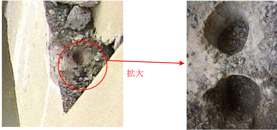
鉄筋コンクリート梁上に設けられたアンカー穴 アンカー穴詳細（トラスNo.20） 写真 3-1(8)：トラス支承部のアンカーボルトが差し込まれていた穴(2015年4月撮影)
