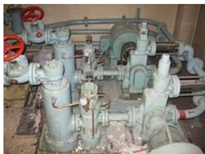
写真1-2(6):圧油装置関係の破損状態(2015年4月27日撮影)
