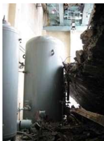
写真1-2(6):圧油装置関係の破損状態(2015年4月27日撮影)
