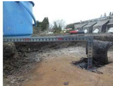
スラブの厚み調査（ドリル削孔して実測調査）
