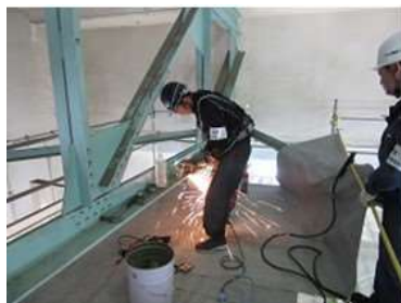
トラス鋼材強度試験のための試験体採取状況
