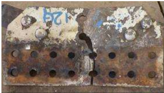
ガセットプレート取り外し後⑤(2015年4月撮影)
