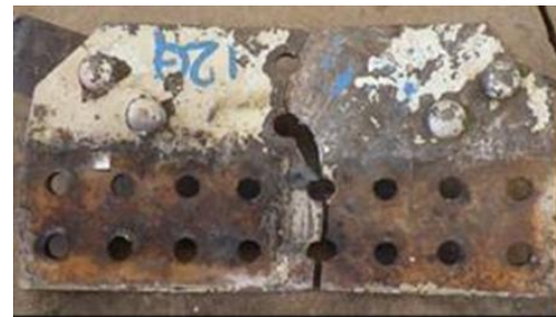
③ ガセットプレートの状況
