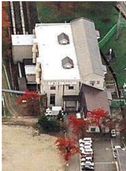
2003年11月撮影 湯沢発電所 外観
