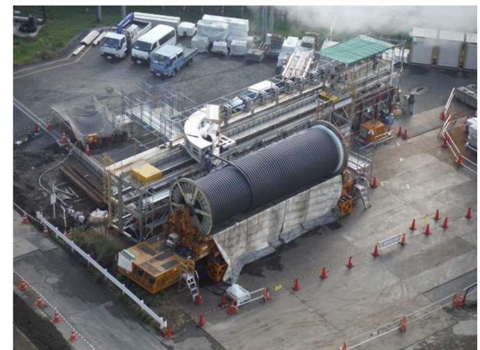
長尺ケーブルを引き入れる工事
