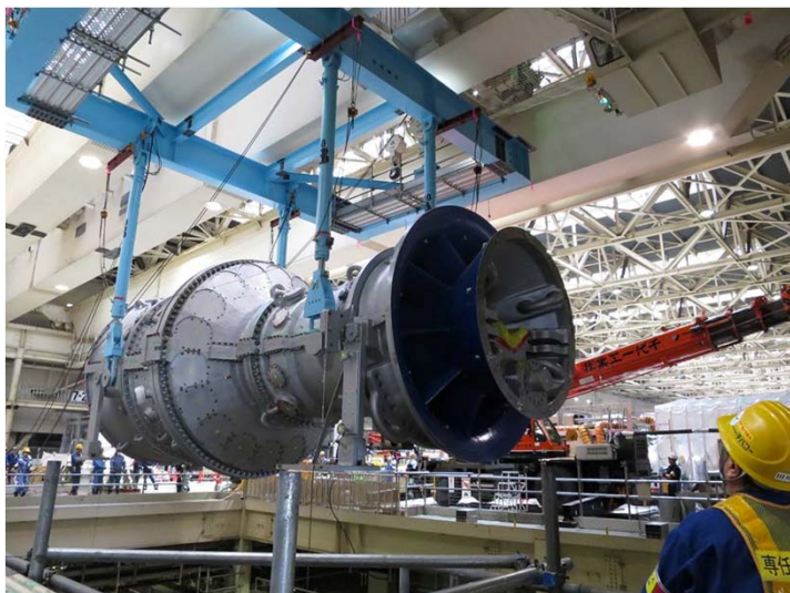
新しいガスタービン設備本体 の吊り上げ作業
