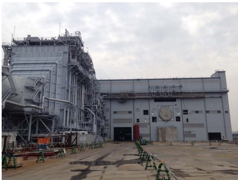
第3軸排熱回収ボイラ設置予定地点
