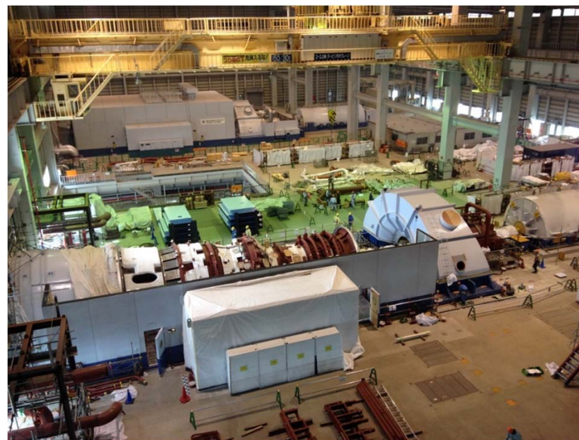
建設中の第3軸タービン設備（手前）
