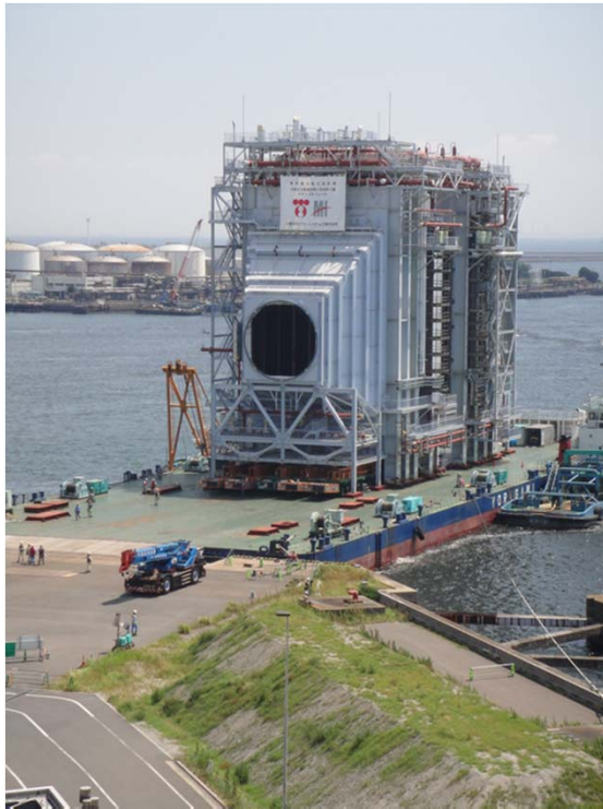
第2軸排熱回収ボイラの陸揚げ
