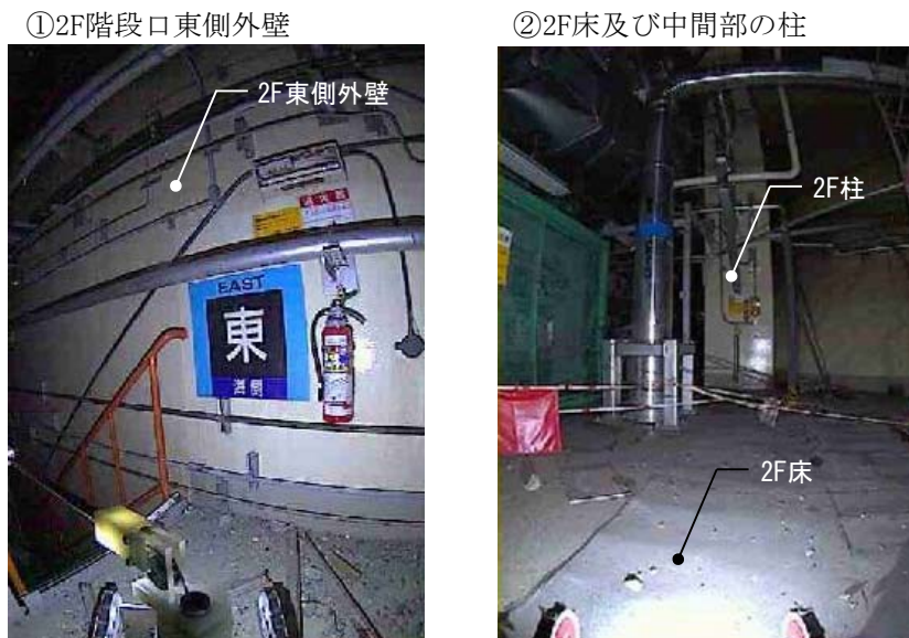
図-2.4(1) 建屋内状況写真（2階）
