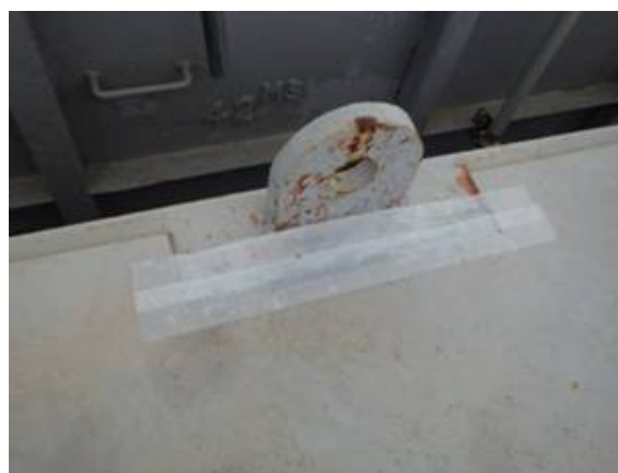
シールテープによる 開口部の目張り状況
