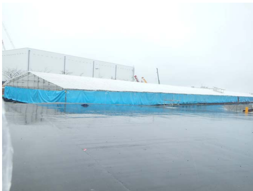
1000トンノッチタンク群への カバー設置状況（最終形）
