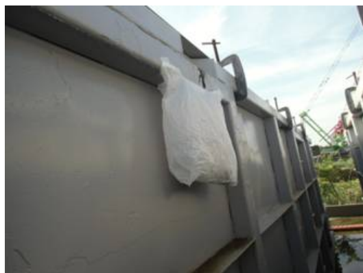
ビニール袋による養生状況
