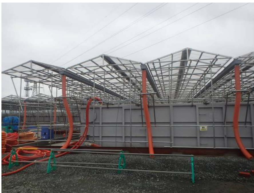
3000トンノッチタンク群への カバー設置状況（最終形）
