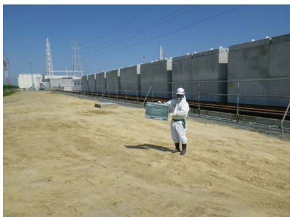
土壌埋め戻し後の状況 (写真は逆方向から撮影)
