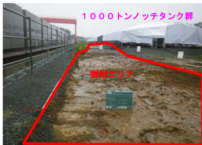
土壌掘削・回収後の状況
