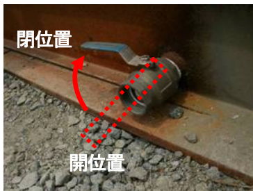
当該堰排水弁（閉状態）
