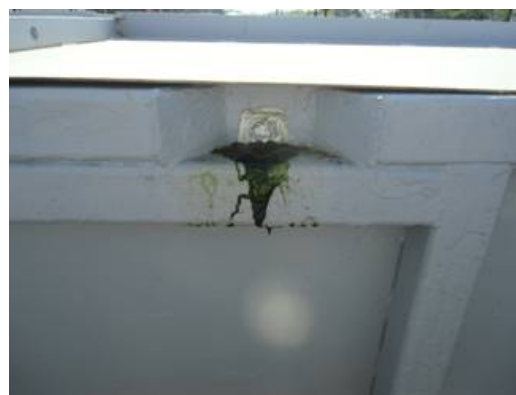
No. 1-5タンク現場状況
