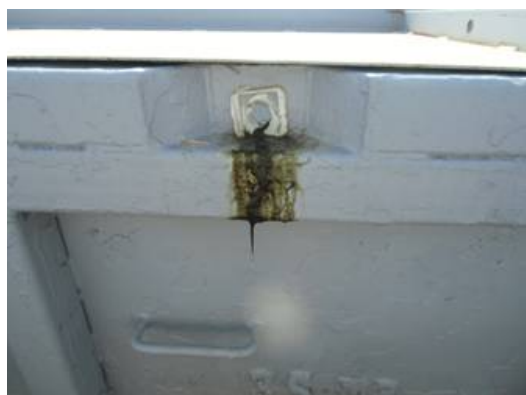
No. 1-3タンク現場状況
