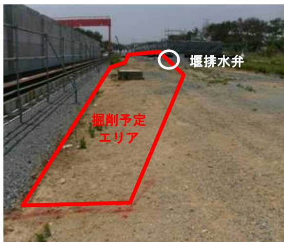
土壌掘削前の状況
