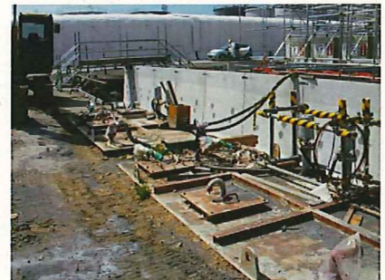
C: 埋め戻し等工事中の状況
