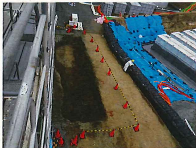
A: 掘削後状況
