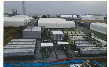
E: 淡水化装置（ボイラ設備）エリア コンクリート基礎フェーシング範囲
