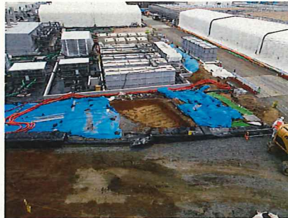
B: 掘削後状況
