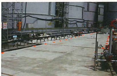
A: 埋め戻し完了後
