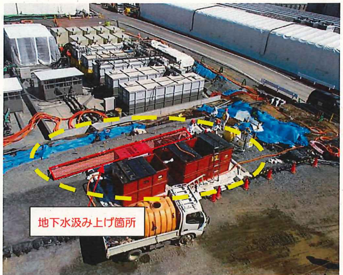
ウェルポイント設置箇所
