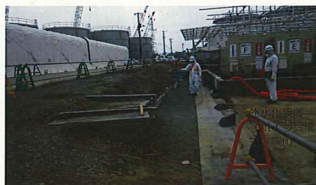
D: 埋め戻し完了後
