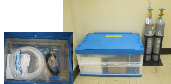
✓ (提案実現例) 緊急時に弁を操作するための資機材を配備
