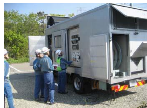
✓ 電源車接続訓練
