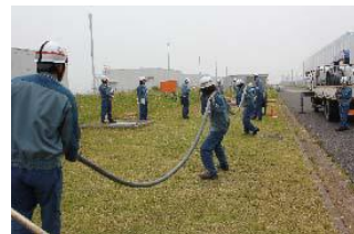
✓ 仮設ケーブル接続訓練
