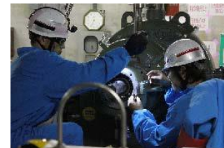
✓ 冷却水ポンプ復旧訓練
