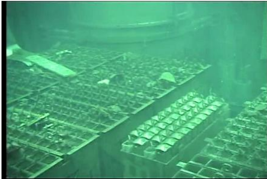
図6-1 4号機SFP内の状況（その1）
