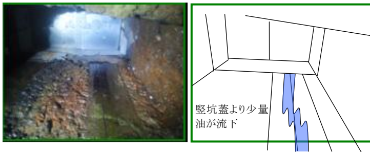
水車発電機室(1F)下部の放水路内から上部に向け撮影 (平成27年1月11日 17時頃撮影)
