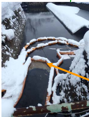
オイルフェンス内油滞留 (平成27年1月11日 10時頃撮影)
