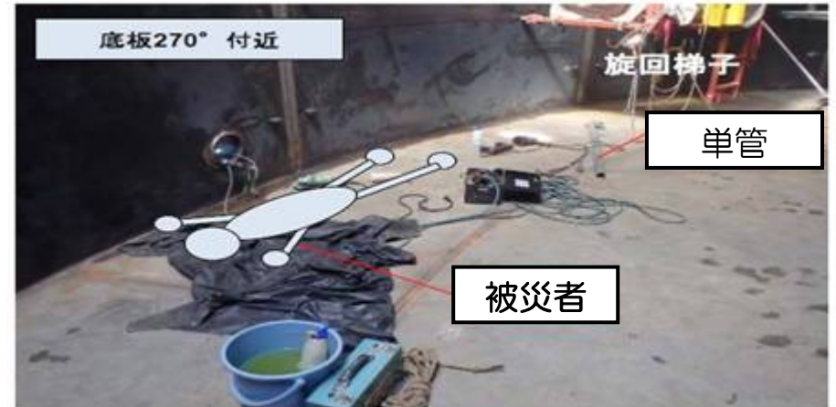
H26.9.20 単管パイプが落下し負傷
