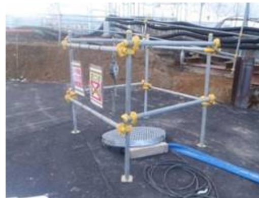
是正後（開口部にバリケードを設置）
