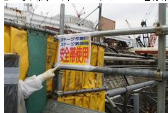
是正後（安全帯使用の標識を設置）
