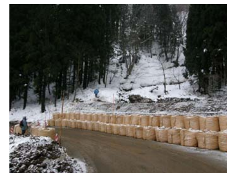
写真-3:道路管理者による応急復旧状況
