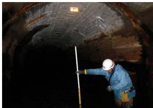
写真-1:水路の調査・点検
