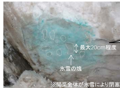
写真-5: 導水路出口 開渠の氷雪
