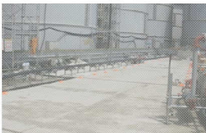
A : 埋め戻し完了後
