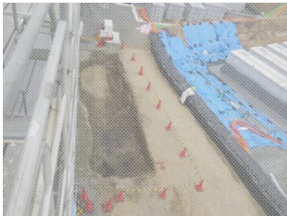
A : 掘削後状況
