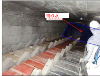
内部写真 (溜り水)
