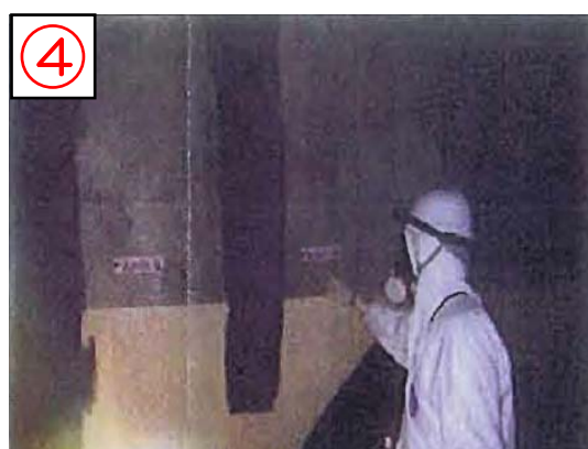
④ 工作建屋西壁補修状況
