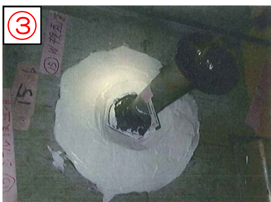
③ 焼却-工作建屋間配管貫通部止水状況
